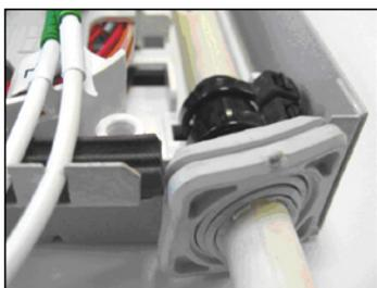
**11** Закрепить ОК в верхней и в нижней частях вставки двумя стяжками нейлоновыми в соответствии с нанесенными на оболочку ОК метками, вводя концы стяжек в прорези на вставке (рисунок 9). Обрезать концы стяжек.
