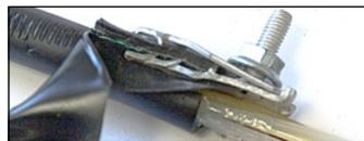
**5.4** Установить нижнюю часть (основание) соединителя Scotchlok 4460-D под отогнутый участок оболочки, поверх ленты ПВХ. Установить верхнюю часть соединителя на шпильку основания и обе части стянуть одной гайкой.
