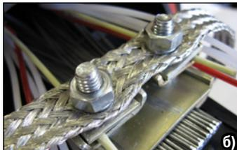
**Примечание** - Электрическое соединение (в соответствии с предусмотренной проектной документацией схемой) между ОК, введенными в овальный патрубок и ОК, введенными в цилиндрические патрубки оголовника, выполнять, подключая отрезок/отрезки ленты-плетенки заземления, установленный на узел крепления:
