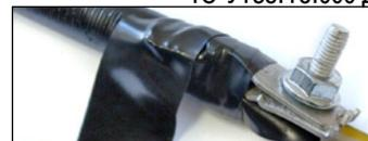
**5.5** Закрепить на ОК соединитель обмоткой из 2-3 слоев ленты ПВХ с 50 % перекрытием.
