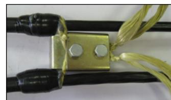
4.7 Для муфт МТОК-Б1; В2(В3); Г2(Г3) с пластмассовым кронштейном - закрепить пучки арамидных нитей в узле крепления силовых элементов ОК на пластмассовом кронштейне муфты.
