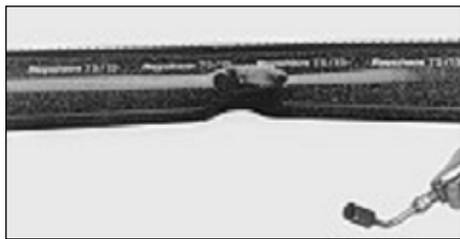
3. При монтаже разветвительной муфты кабели располагать в линию по мере уменьшения их диаметров.
