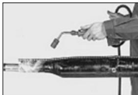
8. Дать остыть ТУТ (ТУМ) до температуры окружающей среды естественным путем (в течение не менее 30 мин.). При монтаже разветвительной муфты выходящие из муфты кабели скрепить стяжкой нейлоновой.
