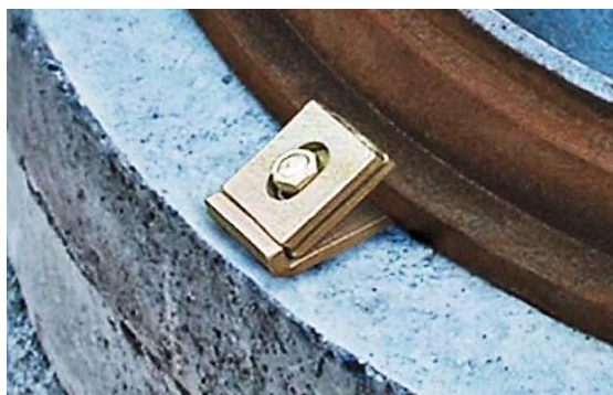
Рис. 6. Накладки и швеллер в рабочем положении на корпусе люка.
