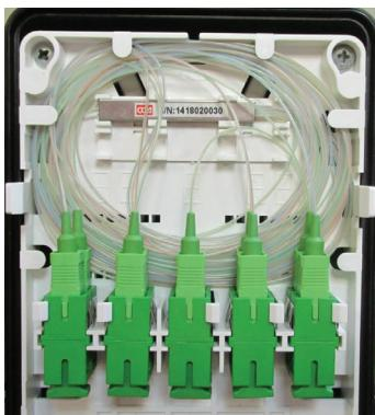
**1.11.2** Выложить оптические шнуры выхода/выходов разветвителей в противоположных
