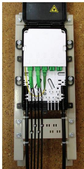
**3.5** В случае ввода в муфту ОКСН (в соответствии с 2) после размещения и закрепления вставки в корпусе муфты зафиксировать кабель за внешнюю оболочку металлическим хомутом на нижнем Т-образном выступе кронштейна, а за внутреннюю оболочку стяжкой полиэтиленовой
