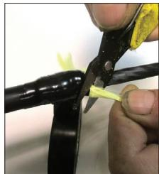
**2.10** Второй слой бандажа ленты ЛВ наложить с перекрытием витков 50 % и вытяжкой, начиная с внутренней оболочки (перекрыв срезы арамидных нитей) и закончив на наружной оболочке кабеля.
