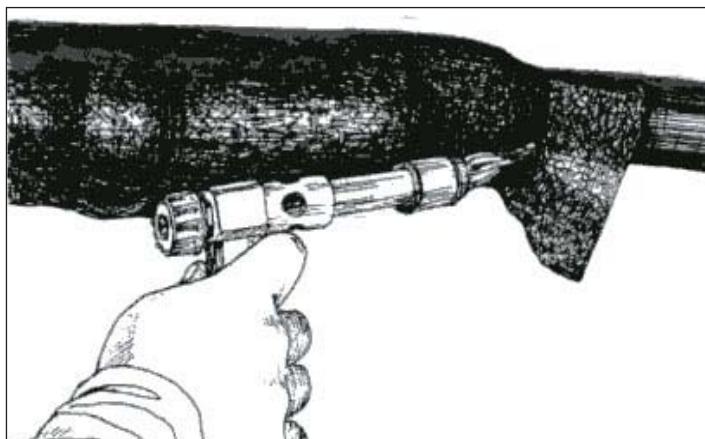
Рис. 4.32. Усадка одной термоусаживаемой трубки на свинцовую муфту
