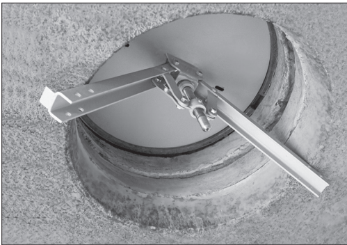
Рисунок 4.2 – Блокировка рычагов УЗНКЛ относительно конструктивных элементов колодца
