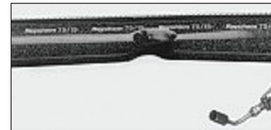
**4.** При монтаже разветвительной муфты кабеля располагать в линию по мере уменьшения их диаметров.
