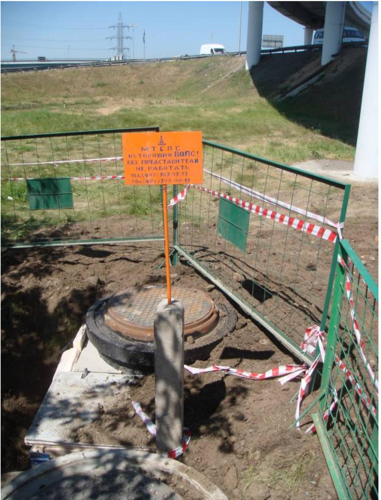
Рис. 11. КПО и колодец для муфт в котловане в процессе засыпки.
