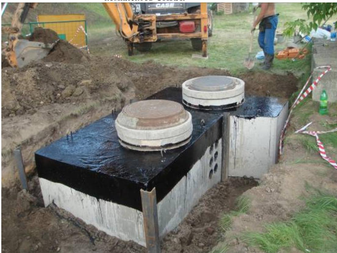
Рис. 8. Гидроизоляция КПО и колодца для муфт.
