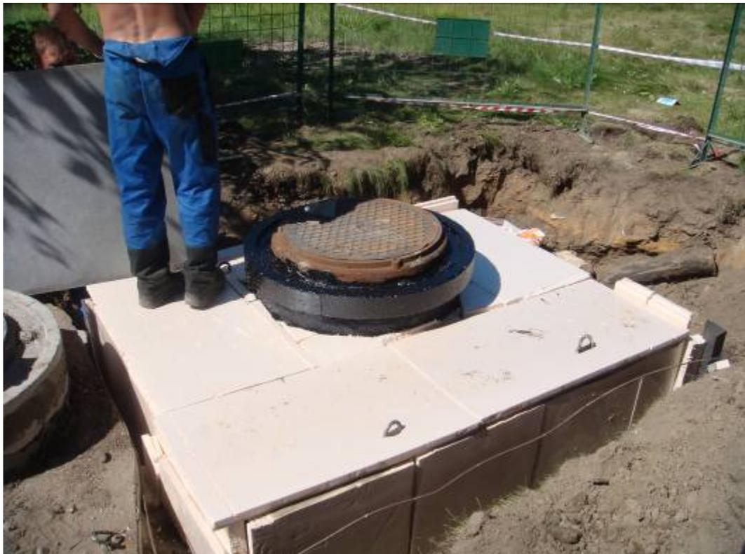
Рис. 10. Окончание установки теплоизоляции.
