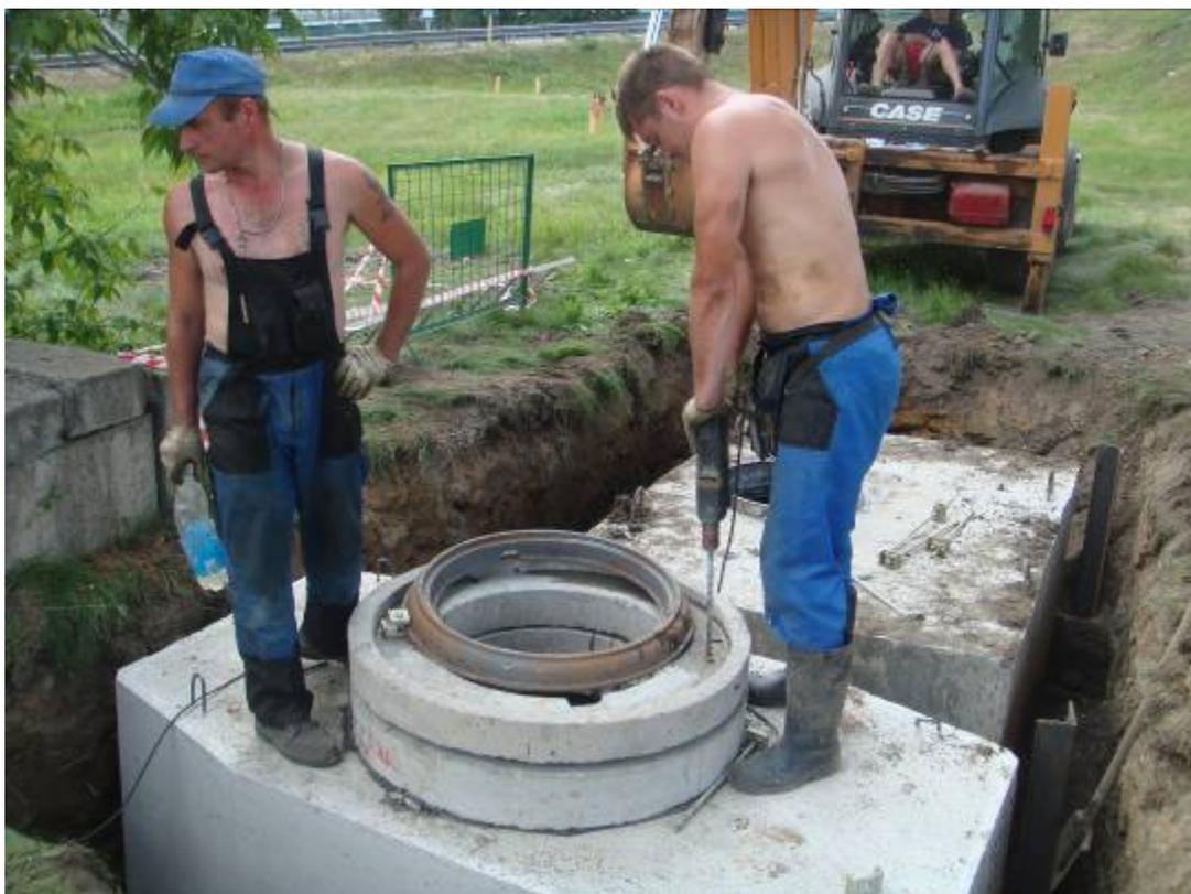
Рис. 7. Крепление системы «люк и опорные кольца» в покрытие колодца с помощью комплектов СНКЛ.
