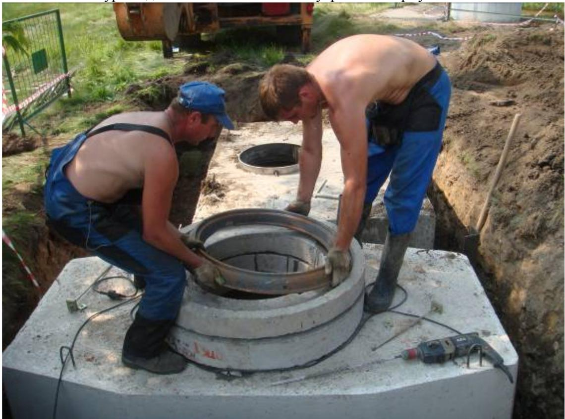
Рис. 6. Установка опорных колец для чугунного люка.
