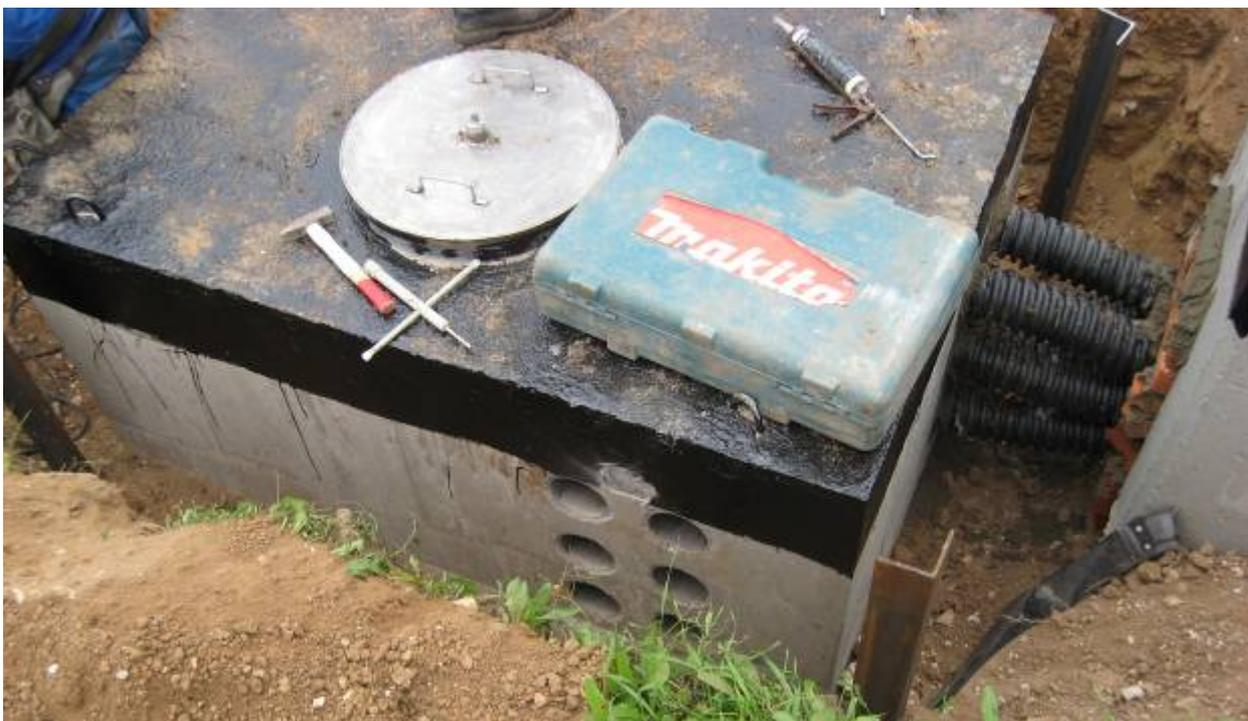
Рис. 12. Вариант соединения КПО и колодца для муфт трубами.
