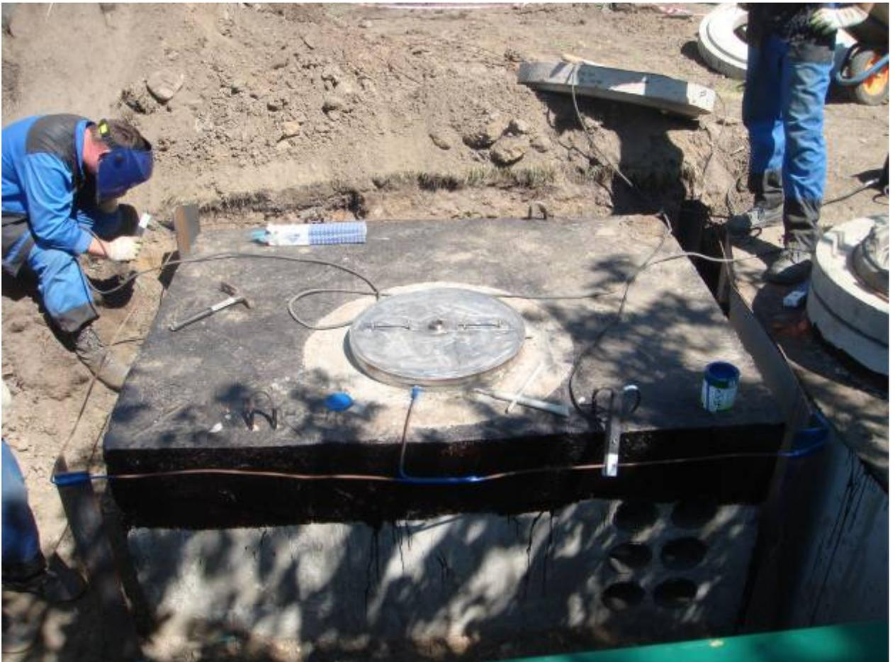
Рис. 5. Соединение элементов контура заземления сваркой.
