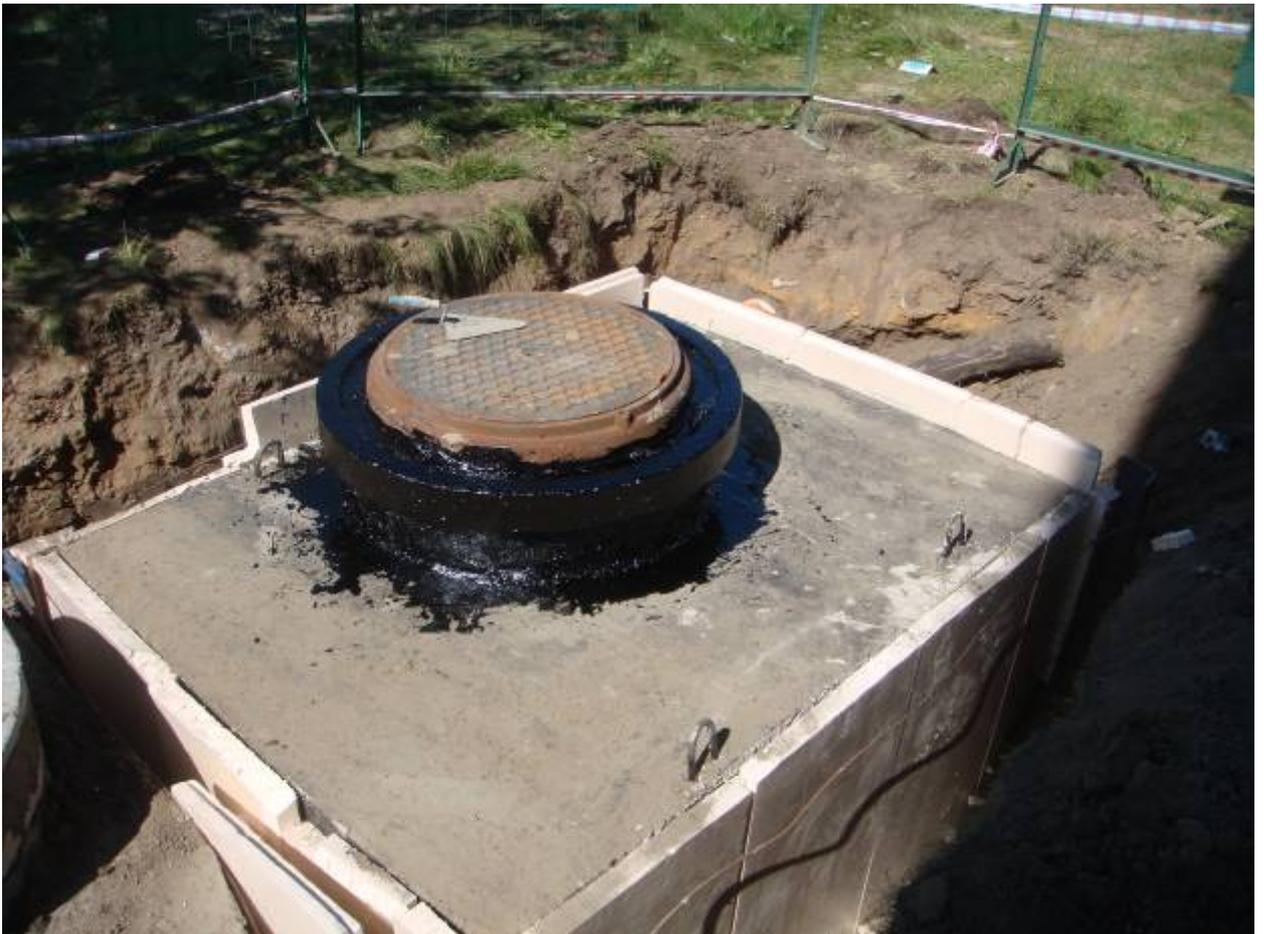
Рис. 9. Теплоизоляция КПО.
