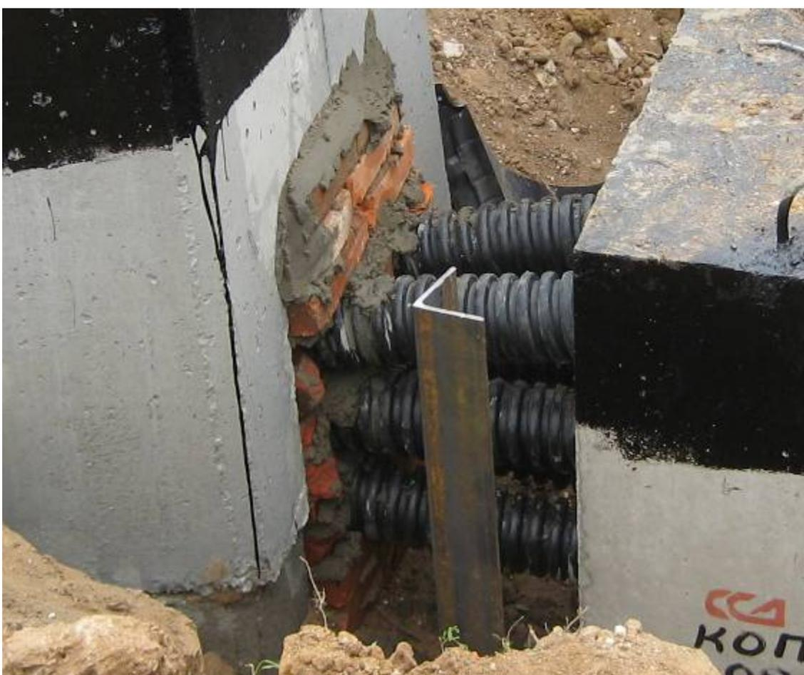
Рис. 13. Трубы EFLEX (FURUKAWA ELECTRIC).
