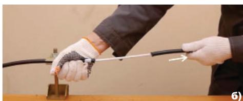
**8** Надвинуть уплотнительный элемент кабельного ввода на сердечник ОК и аккуратно продвинуть к месту среза наружной оболочки.
