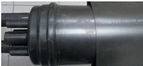
**21.** Установить поверх хомута и усадить трубку ТУТ 180/58 для герметизации стыка кожуха и оголовника.
