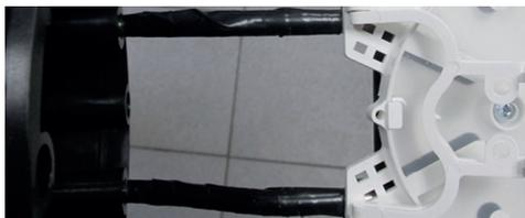
9. Выполнить разделку внутренней оболочки ОК в соответствии со схемой, с применением ножа кабельного или специальных инструментов.
