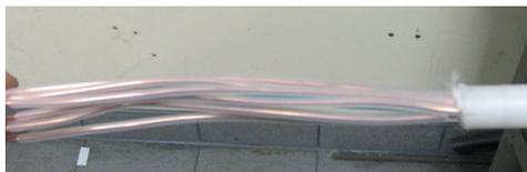
12. Надвинуть трубку ТУТ 19/5 длиной 50 мм на стык внутренней изолирующей оболоч-
