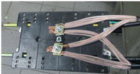
**15.** Завести ОМ на кассету. Отметив место обреза ОМ на вводе в кассету, сделать по нему надрез и удалить оболочку ОМ с помощью стриппера. Протереть каждое ОВ безворсовой салфеткой (Kim-Wipes), смоченной изопропиловым спиртом, далее насухо вытереть. Закрепить ОМ на вводе в кассету КТ-3645 двумя стяжками нейлоновыми, предварительно наложив на ОМ в месте его крепления бандаж из 2-3 витков ленты 88Т.
