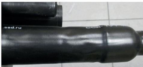
**20.** Установить кожух муфты, стык его с оголовником скрепить пластмассовым хомутом. Обезжирить поверхности кожуха, оголовника и хомутов, произвести их зачистку по окружности с помощью шкурки шлифовальной, после чего протереть поверхности сухой чистой ветошью. Прогреть пламенем газовой горелки поверхность муфты на
