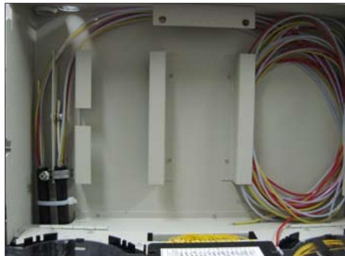
Рисунок 5.5 – Ввод абонентского ОК через нижний кабельный ввод
