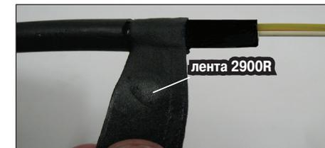
**4.5** Ввести нижнюю часть соединителя Scotchlok 4460-D между внутренней оболочкой с наложенной на нее лентой 2900R и наружной оболочкой, под стальную гофрированную ленту.
