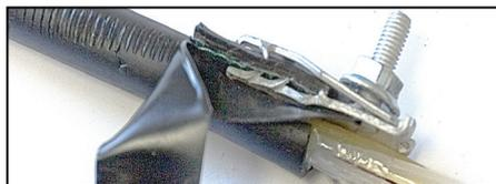
**3.5** Закрепить на ОК соединитель обмоткой из 2-3 слоев ленты ПВХ с 50 % перекрытием.
