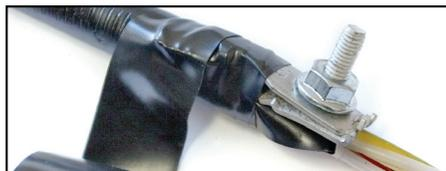
**3.6** Разобрать сердечник ОК на отдельные элементы скрутки, обрезать кордели. Обрезать ЦСЭ в соответствии с размерами, приведенными в таблице. Удалить межмодульный гидрофобный наполнитель.
