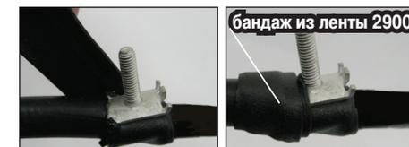
**4.7** Установить на нижнюю часть соединителя Scotchlok 4460-D верхнюю часть соединителя и скрепить обе части гайкой. Наложить на соединитель и на прилегающие к нему участки ОК бандаж из двух-трех слоев ленты ПВХ на длине около 10 мм.
