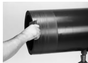
Фото 4.2.6. Снятие фаски для облегчения одевания муфты
