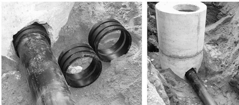
Фото 2.1. Защитные муфты для входа в бетонный колодец
