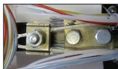
**Примечание** – Если ЦСЭ представляет собой стальной трос с полимерным покрытием, выполнить электрическое соединение ЦСЭ с броней ОК, используя перемычку электрического соединения.
