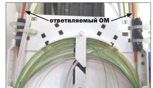
**7.1.3** Предварительно выложить запас длины ОВ (основное и резервное) ответвляемого ОМ кабеля направления «А», предназначенные для подключения ко входу разветвителя, в направляющих элементах кассеты, завести их в среднее гнездо ложемента. Обрезать ОВ на выходе из ложемента. Уложить запасы длины других ОВ из состава монтируемого ОМ линейного ОК в кассете.
