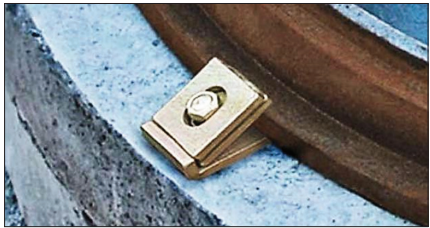
Рис. 6. Накладки и швеллер в рабочем положении на корпусе люка.
