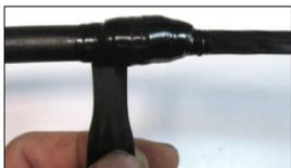
**2.11** Удалить внутреннюю оболочку ОК по принятой технологии на длине 2 м, отступив от банджа на 70 мм.
