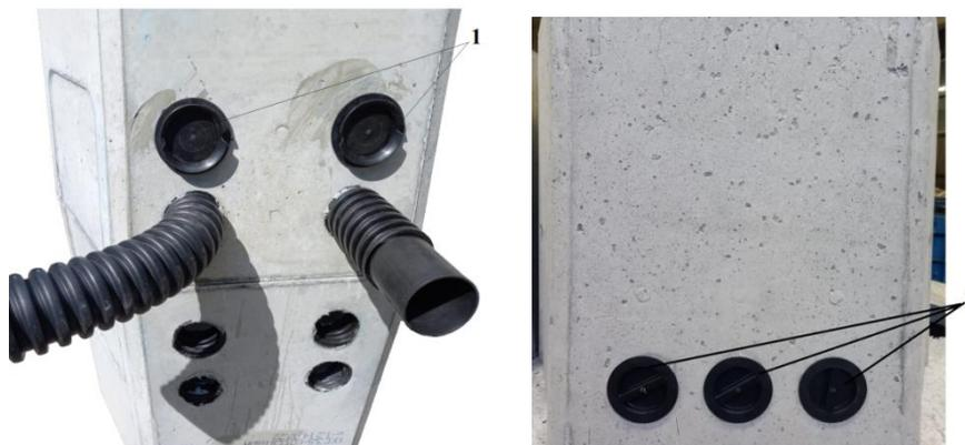
Рис. 4.1. Установленные заглушки в закладные элементы колодцев ССД-Пайп: 1 – заглушки.
