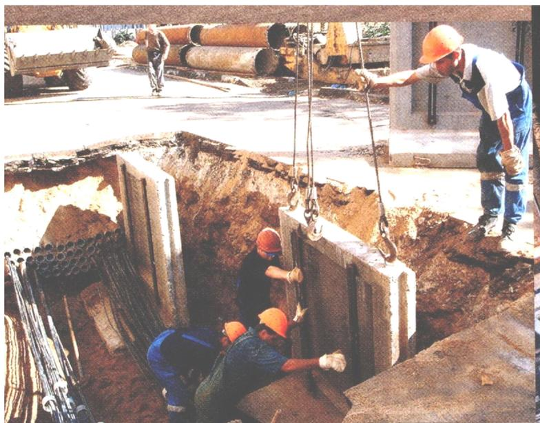
Рис. 4.2. Сборка проходного колодца типа «ККС» на пакете каналов, часть которых уже занята действующими кабелями.
