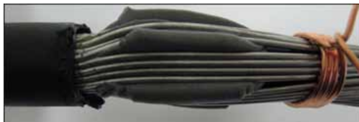
Рисунок 4.35 – Наложение бандажа из проволоки
