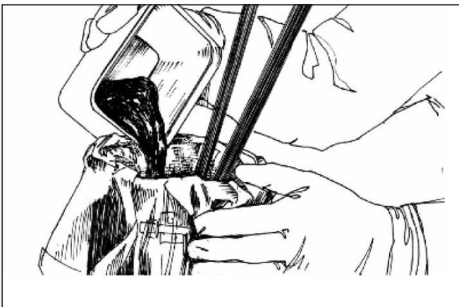
**3** Надеть на руки защитные перчатки. Смешать в емкости два компонента герметика ВИЛАД-31 (А и Б). Расположить муфту МЧЗ кабельными вводами вверх. Залить в пространство между большим и малым полиэтиленовыми пакетами смешанные компоненты герметика.
