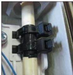
**15** Завести ОК в технологические прорези корпуса кросса, устанавливая при этом вводы кабельные на их штатные места.
