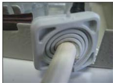
**14** Закрепить ОК в верхней и в нижней частях вставки четырьмя стяжками нейлоновыми в соответствии с нанесенными на оболочку ОК метками, вводя концы стяжек в прорези на вставке (рисунок 8). Обрезать концы стяжек.
