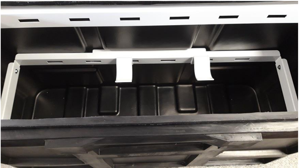
Рис. 18. Две консоли КСО-1 установлены на продольном кронштейне.
