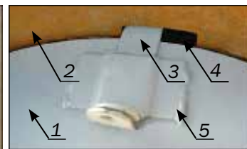
Рисунок 1.3 – Задвижка и упор нижней крышки 1 - нижняя крышка; 2 - корпус люка; 3 - задвижка; 4 - паз корпуса люка; 5 - упор
