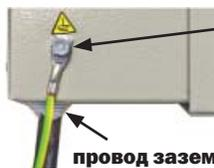
**болт и гайка М6 крепления клеммы провода заземления к корпусу кросса**
